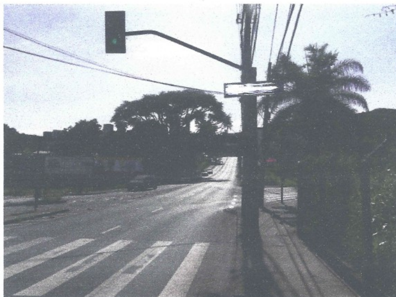
Poste para braço projetado engastado
